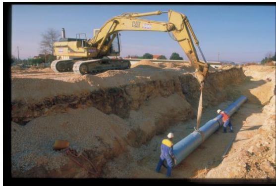
Travaux sur réseaux d'assainissement Photo : Rémi Lengereau
