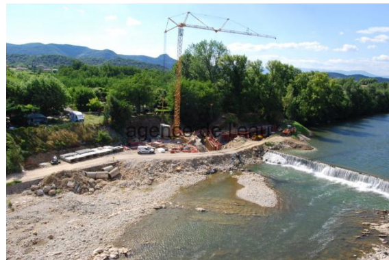
Construction d'une passe à poisson sur l'Ardèche Photo : Christine Condé
