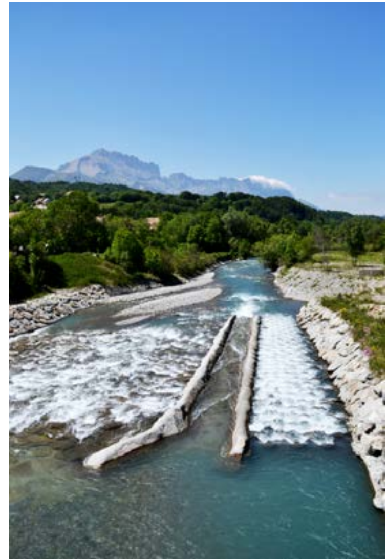
Passage d'un seuil : les poissons utiliseront le passage de droite, les kayaks celui du milieu.
