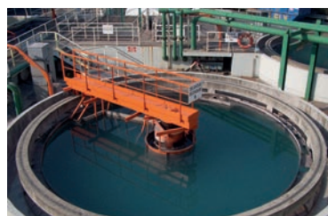
Sur le site de Tefal à Rumilly, un traitement en fin de process à la station d'épuration vise l'abatement de 90 % des micropolluants.
