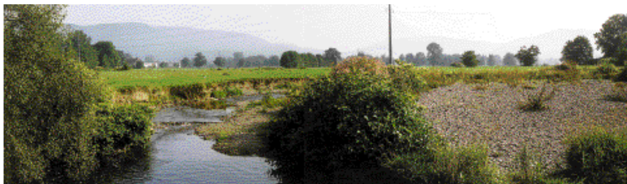
Un atterrissement sur la Moselle.
