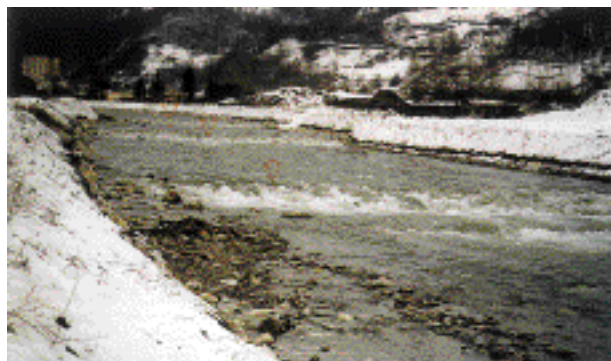
Seuils multiples sur l'Arly en Savoie.
