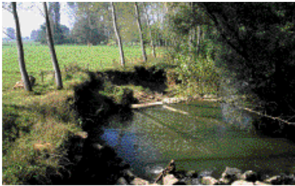
Érosion de berges sur la Vallière (Jura).
