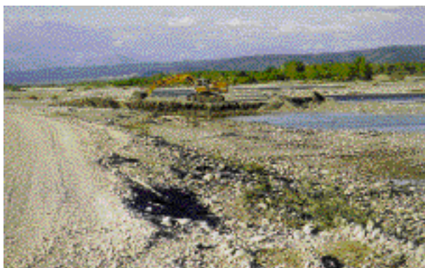
Deux types d'extractions en lit mineur : à gauche, un arasement de bancs hors d'eau sur la Durance ; à droite, des dragages en souilles profondes.
