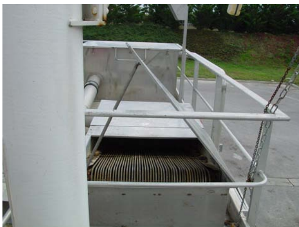
Photo 3 : dégrilleur automatique
