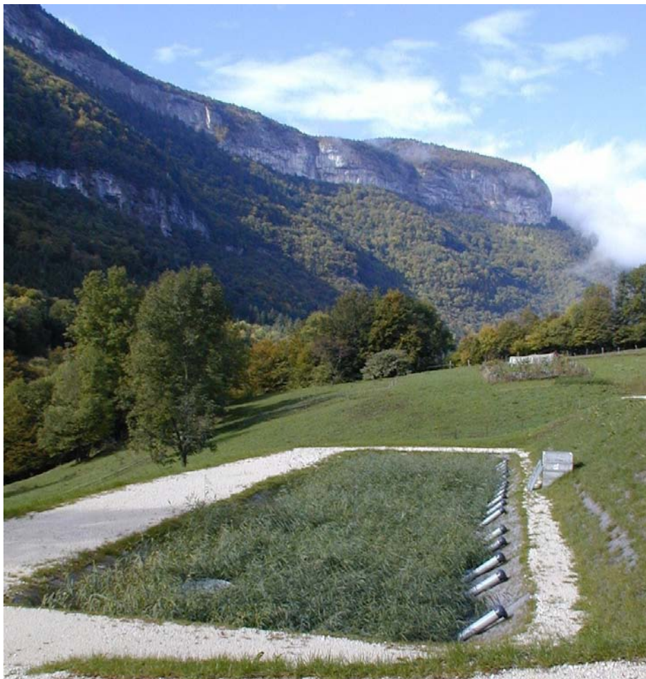
Photo 5 : Filtres plantés de roseaux
