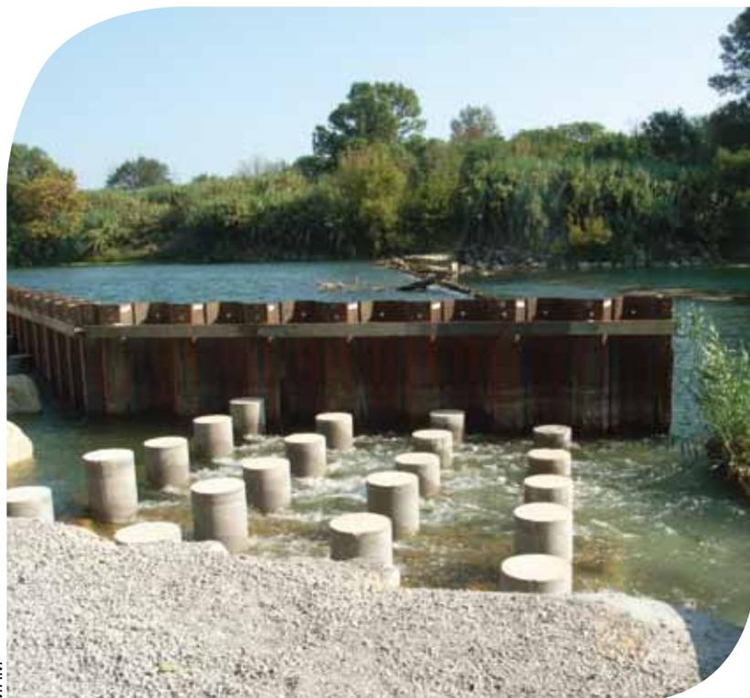
Aménagement du seuil de Callet, sur le Gardon (Gard) : dispositif équipé de plots et d'une rugosité de fonds à base d'enrochements de petite taille de façon à limiter les vitesses d'écoulement pour faciliter le passage des poissons.
