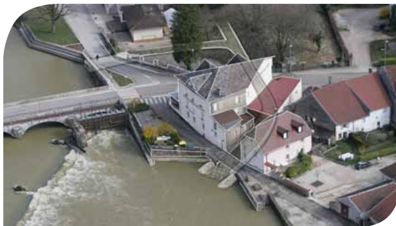
La passe à poissons souterraine de Quingey.
