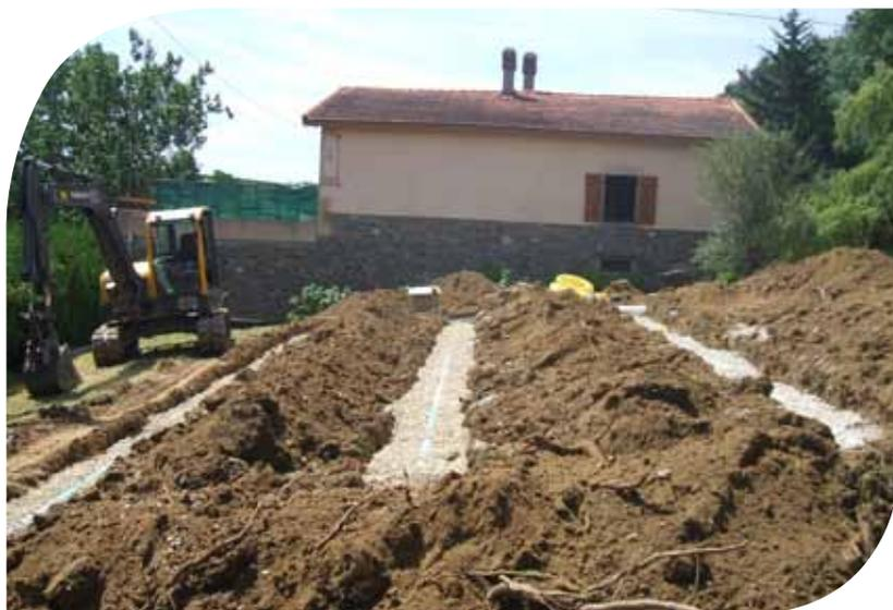
Installation d'assainissement autonome : tranchées d'épandages réalisées sur un terrain en pente.
