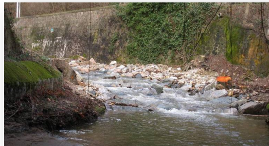
Effacement de seuil sur le ruisseau de Charbonnières (69) - ONEMA
