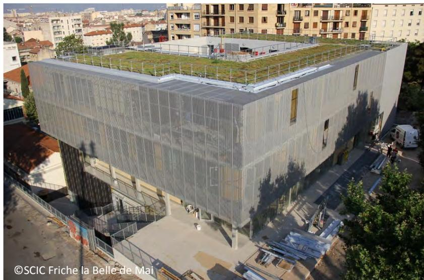
34 m<sup>3</sup> d'eaux de pluie vont être stockées grâce à l'aménagement de 568m<sup>2</sup> de toiture végétalisée. Cette rétention permettra d'alléger les surcharges hydrauliques du réseau de Marseille.
