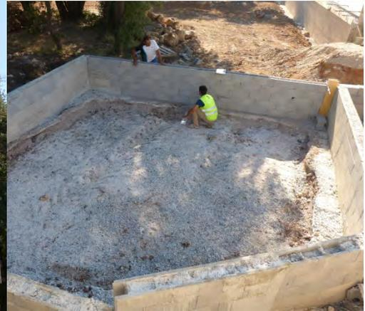
L'aménagement du bassin de rétention/infiltration de 700 m<sup>3</sup> et la création d'une noue d'infiltration vont permettre de limiter les apports d'eaux pluviales au Salaison.
