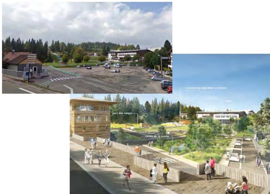
8 500 m<sup>2</sup> sont désimperméabilisés lors du réaménagement de la RN5. Ce sont 2 500 m<sup>3</sup> d'eau de pluie qui peuvent être stockés et infiltrés grâce à des noues, des jardins creux....
