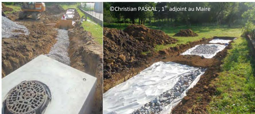
Le traitement des eaux pluviales par une noue étagée et végétalisée va permettre de protéger la zone humide du marais de Saône. Et participer ainsi à l'amélioration de la qualité des eaux incluses dans le périmètre de protection rapproché du captage de la source d'Arcier.
