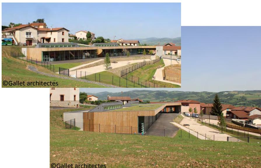
450 m<sup>2</sup> de toiture végétalisée connectés à une cuve de stockage de 10m<sup>3</sup> permettent de récupérer les eaux de pluies pour les réutiliser.
