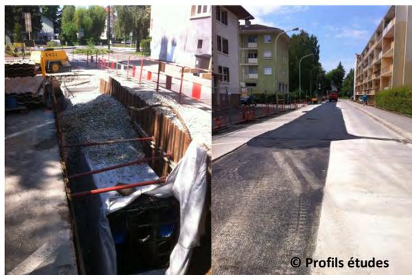
33 000 m<sup>2</sup> en centre-ville sont déconnectés pour infiltrer les eaux de pluie dans des bassins de rétention/infiltration souterrain (sous une cour d'école, sous un parking...). 2 100 m<sup>3</sup> sont ainsi stockés puis infiltrés.
