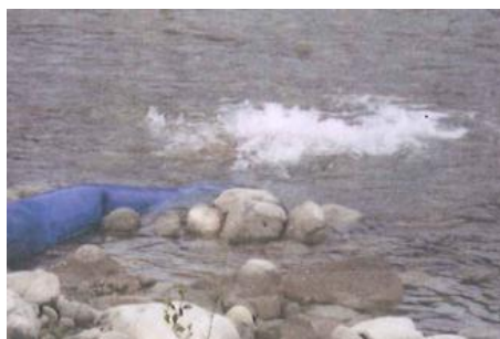
Pompage d'essai Site du Bec de l'Estéron Septembre 2014
