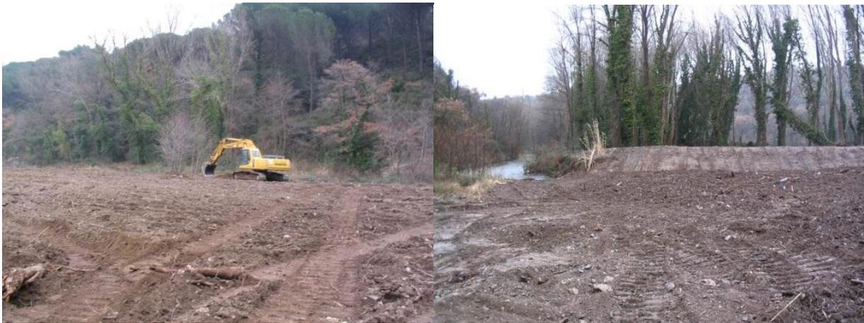
*Travaux de terrassement et édification d'une digue perpendiculaire au cours d'eau permettant de stocker plus d'eau dans le champ d'expansion de crues.*
