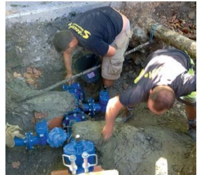
Des travaux sur le réseau d'eau potable de Buis-les-Baronnies (Drôme) à partir de mai permettront d'obtenir un **rendement de plus de 73 %** en économisant environ 45 000 m<sup>3</sup> d'eau par an, au bénéfice du bassin de l'Ouvèze provençale en déficit quantitatif. Une première série d'interventions sur 3 km, en 2013 et 2014 dans la commune de Buis, avait porté le rendement à 69 %. Quatre autres tranches de travaux sont prévues d'ici à 2018.
