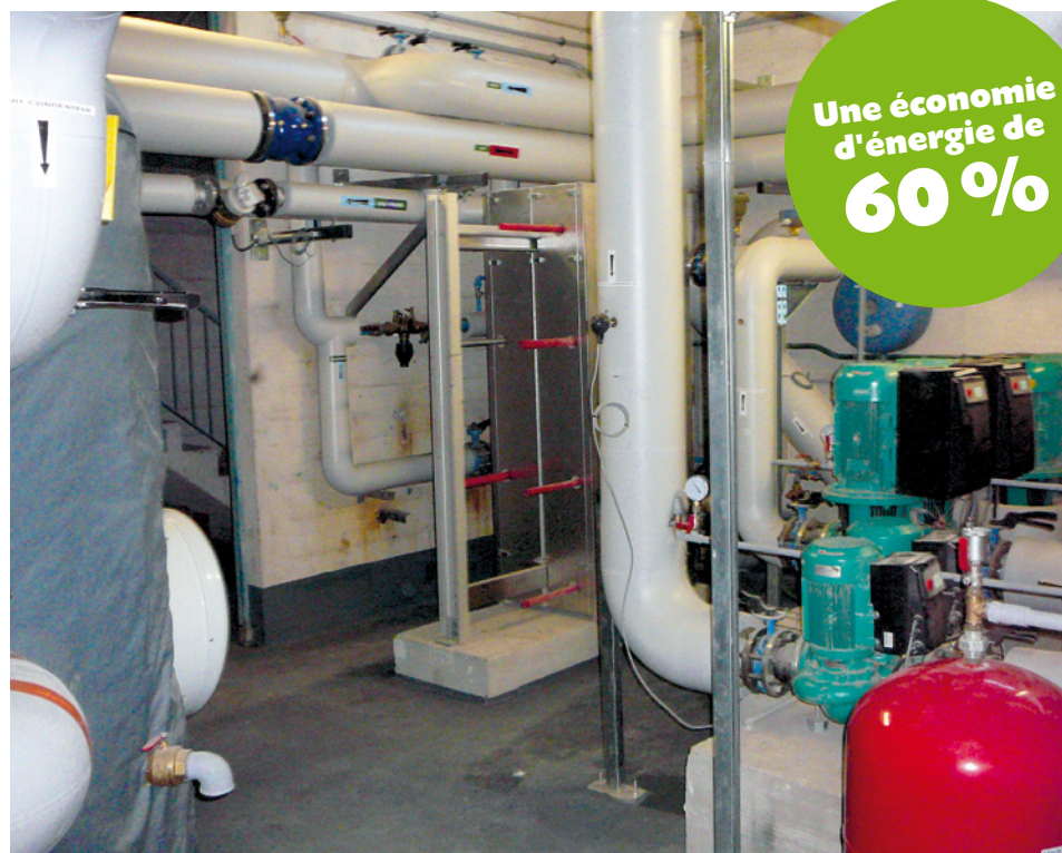
■ Le système de récupération d'énergie thermique des eaux usées à la résidence des Chartreux, à Marseille.
