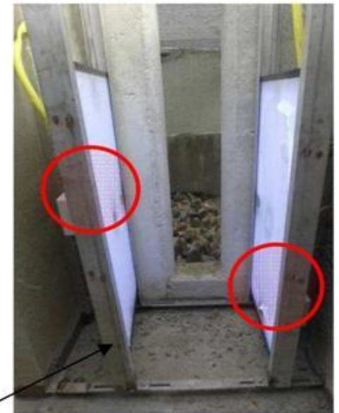
Vue des plaques avec la position des caméras en amont de la fente, avant mise en service (Hizkia)
