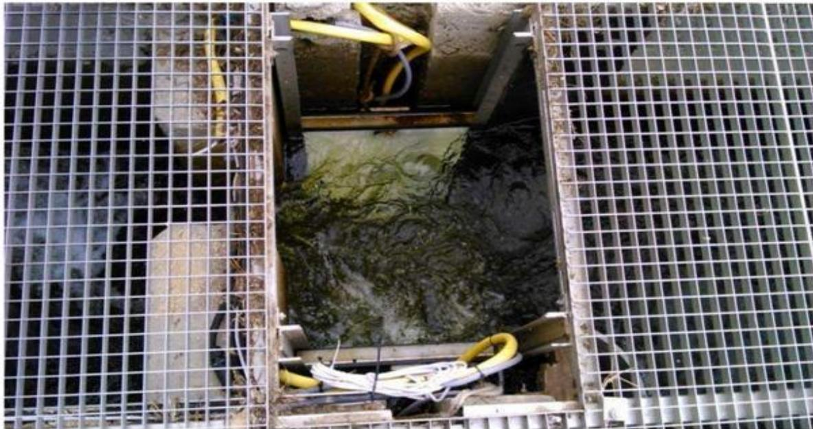
Vue des plaques dans le bassin amont de la passe à poisson de la Rampe-rouge, passe en fonctionnement
