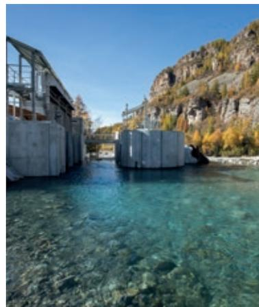
À Champsaur (05), le barrage des Ricous, sur le Drac, a bénéficié de travaux de mise en conformité écologique qui se sont achevés début 2015. Ils ont permis d'aménager **une passe à poissons**, de rétablir le transport sédimentaire et de réguler le flux selon les besoins, grâce à un dispositif de vannes motorisées. Portés par l'association syndicale autorisée du canal de Gap, ces travaux ont coûté 3,9 M€, dont 45 % de l'agence de l'eau.
