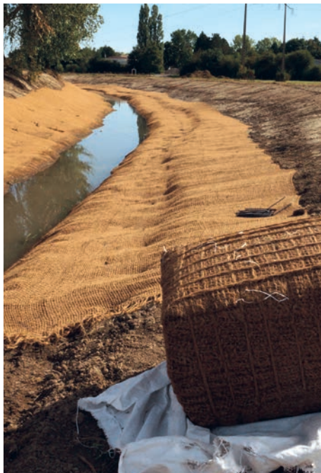
■ Balle de géotextile coco avant la pose sur la berge.
