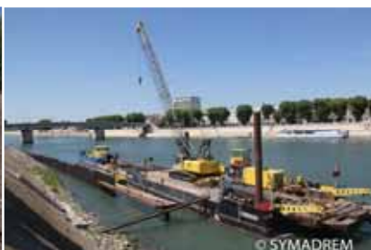
Le quai Max Dormoy pendant les travaux
