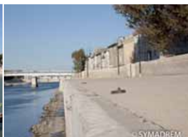
Le quai de la Roquette après travaux
