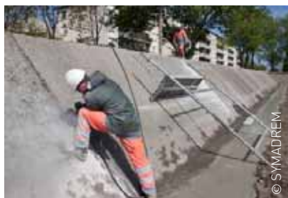
Travaux de sécurisation des digues
