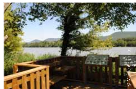
Aménagement autour de la halte fluviale de Cruas (Ardèche)
