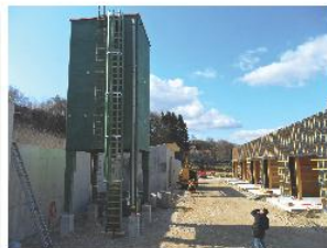
Le silo à sel.
