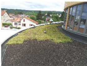
La toiture végétalisée.
