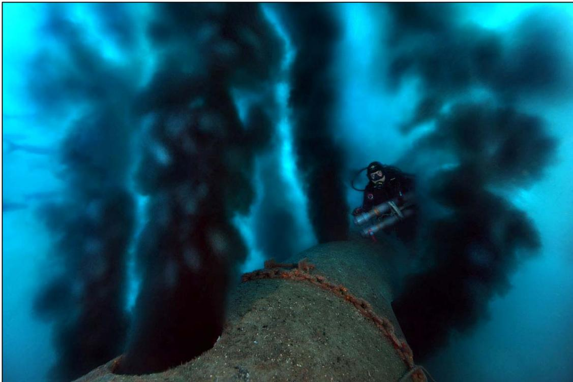
Figure 4 : rejet en mer de la STEU de Fréjus avant mise aux normes et traitement biologique
