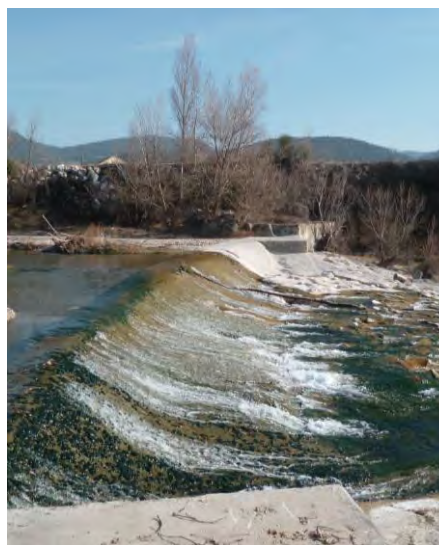
Seuil en aval d'un rejet de station d'épuration
