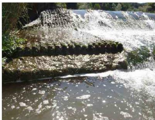
Seuil de Gordes, dalle à plots actuelle avec vue sur le décrochement © SABA
