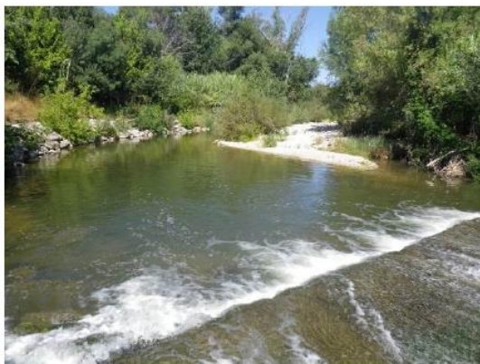
Aval du seuil de Gordes © SABA
