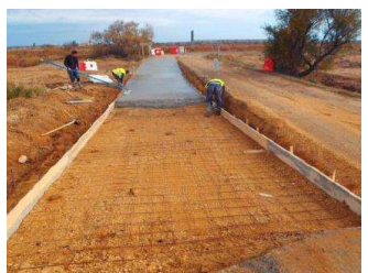
Route des plages, création d'un passage submersible avant et après travaux © EPTB Orb-Libron
