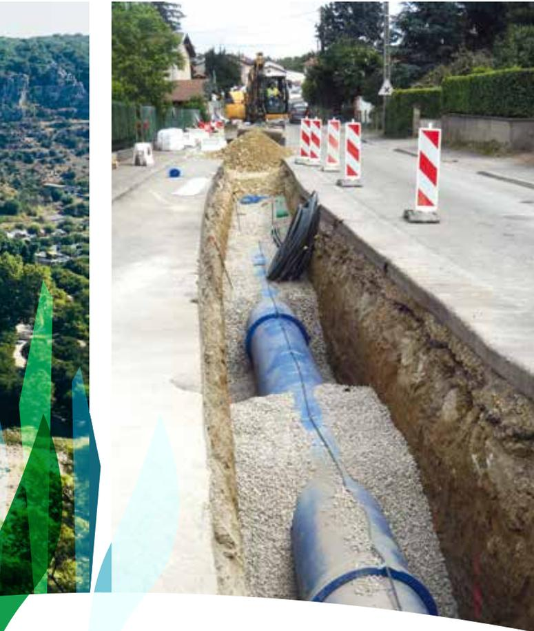
■ La ville de Vienne vise une économie de 1,3 million de m<sup>3</sup> d'eau potable par an grâce au remplacement de 6 kilomètres d'une canalisation vieille de 40 ans.
