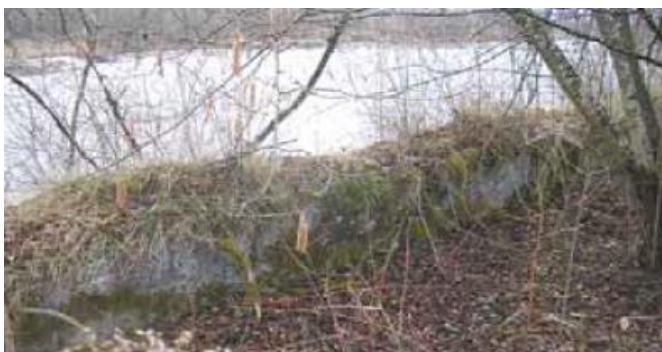
Mur déconnectant l'Arve des anciennes gravières
