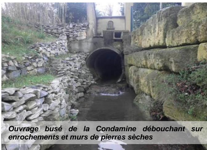
*Ouvrage busé de la Condamine débouchant sur enrochements et murs de pierres sèches*
