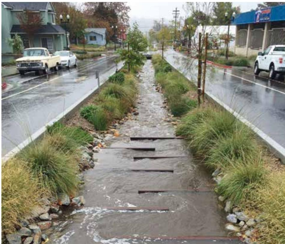
■ Exemple de « rue-rivière » permettant de canaliser le passage des eaux de pluie torrentielles en ville.
