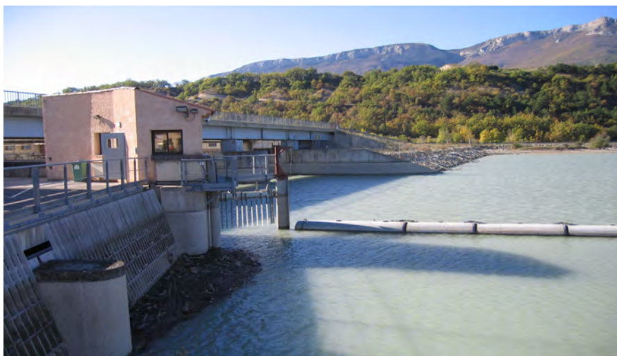
Barrage EDF de Saint Sauveur
