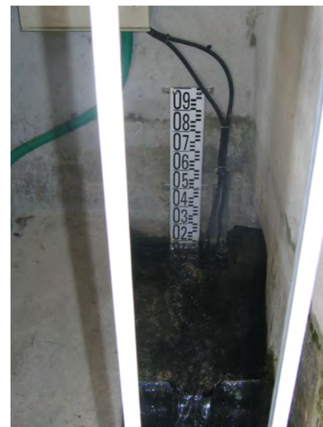
Station hydrométrique Source de la Gerle (Buëch)
