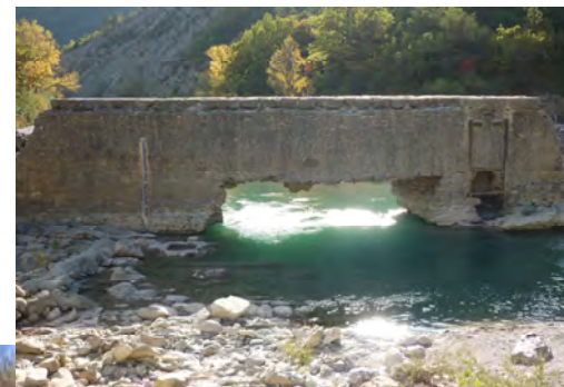
Station hydrométrique sur le Buëch
