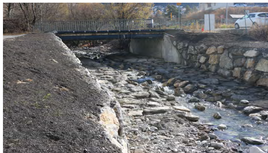
Amélioration de la franchissabilité piscicole du radier du pont de la RD136 (torrent des Ayes)
