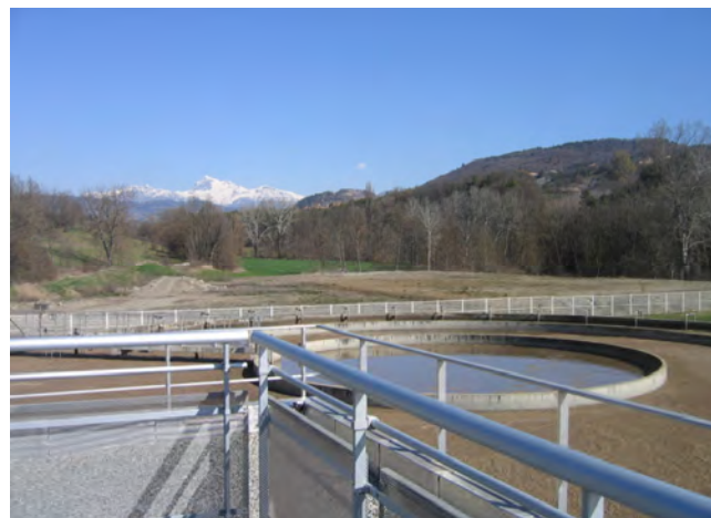
Station d'épuration de Gap
