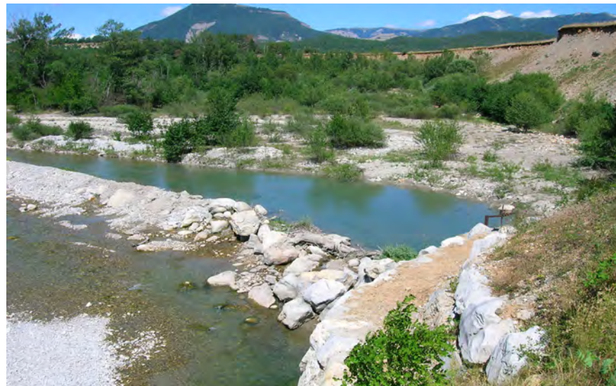
Canal du Béal sur le Buëch
