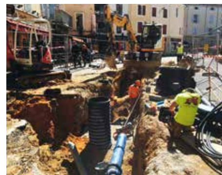
■ La réduction des fuites d'eau potable est recherchée grâce aux travaux de renouvellement des réseaux.
