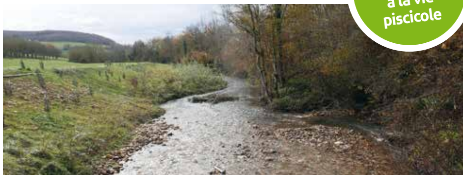
■ Le gravier nécessaire au rehaussement du lit de l'Herbasse a été ponctionné en aval, avant d'être réinjecté 15 kilomètres plus haut.
