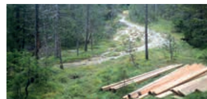
■ Restauration de la zone humide de Termignon.
