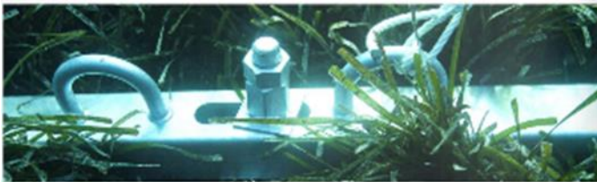
Implantation des vis filaires hélicoïdales
