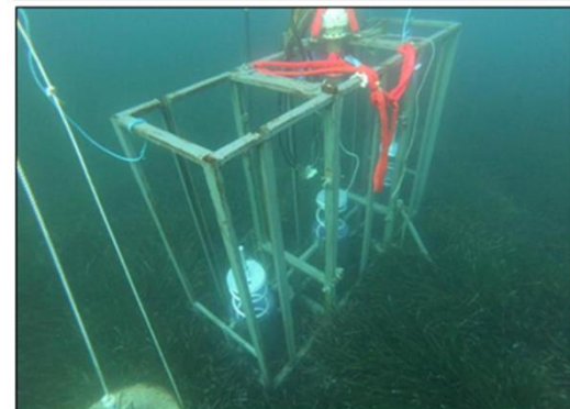
Implantation des vis filaires hélicoïdales
