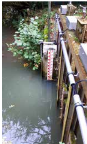
VNF a installé une trentaine de capteurs et de sondes pour adapter sa consommation en temps réel.
