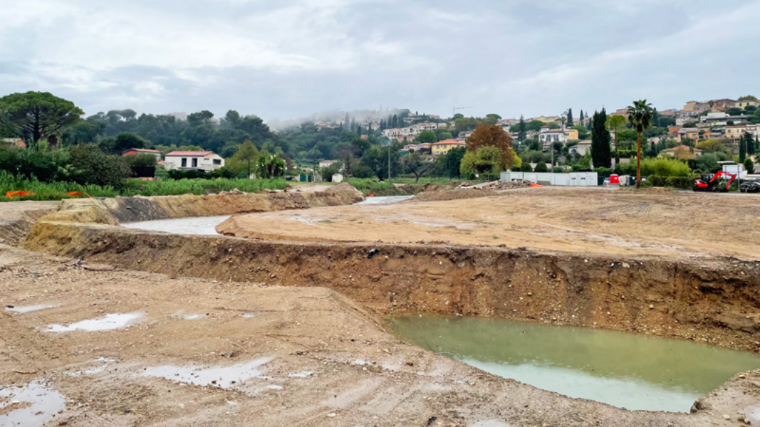
Les berges de la Brague ont été réaménagées en pente douce ; elles accueilleront à terme un cheminement pour les piétons et les cyclistes, ainsi qu'un parcours pédagogique autour de la culture du risque.
