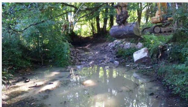
Destruction de l'ouvrage (à gauche) et vue du site depuis l'amont après comblement de la fosse (à droite) © FDPPMA52
