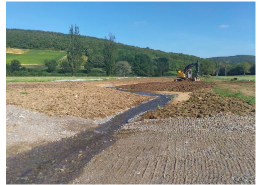
Travaux été 2021 © CD71
