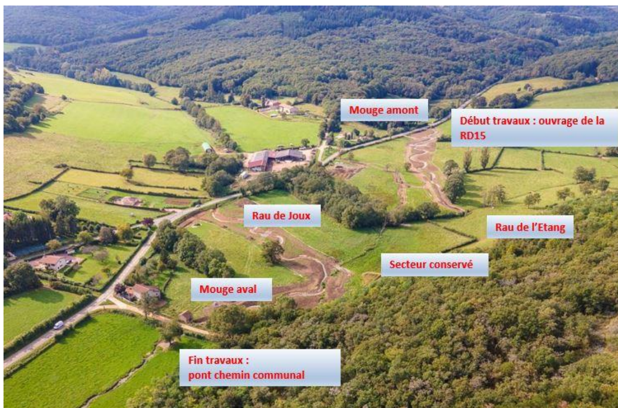
Vue drone travaux © CD71
