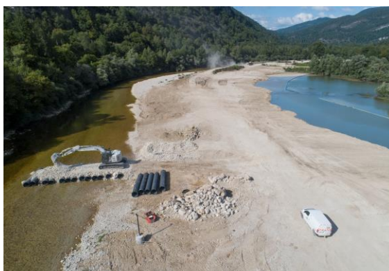
Mise en place passage temporaire pour scarification du banc en rive droite et reconnexion d'un bras secondaire © Romain Bellier PNRHJ
