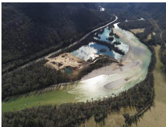
Site après travaux et 2 crues © Geoffrey Visi PNRHJ
