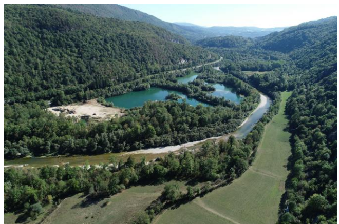
Photo du site avant travaux, les contraintes latérales sont cachées par la végétation © Romain Bellier PNRHJ
