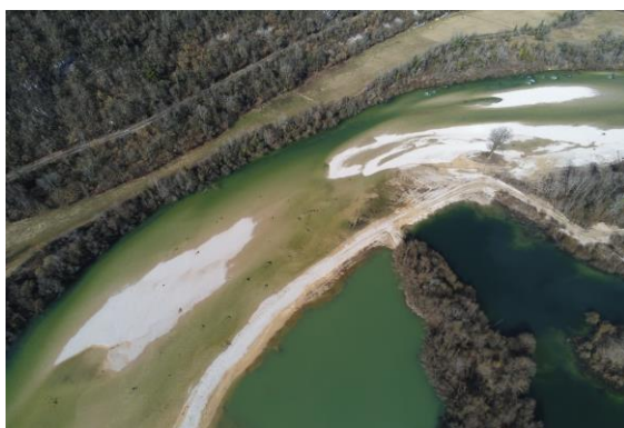
Site après travaux et 2 crues © Geoffrey Visi PNRHJ
