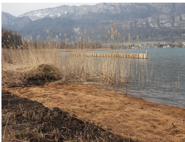
Secteur en interface avec le lac, protégé de l'érosion par un filet coco - Février 2022 © Asters-CEN74
