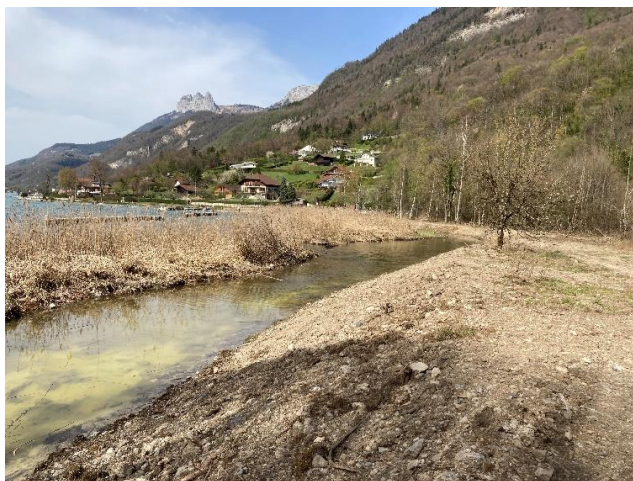
Berges déblayées après travaux - Février 2022 © Asters-CEN74
