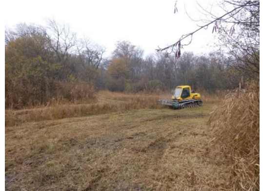
Après les travaux - Février 2022, Période sans pluie depuis 3 semaines © Asters-CEN74
