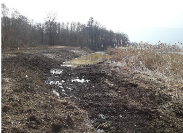
Berges déblayées après travaux - Février 2022 © Asters-CEN74
