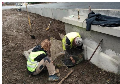
Comptage n+1, après-travaux © SM3A 2022
