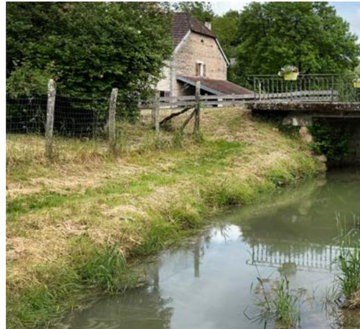
En rive droite, un dalot a été posé pour augmenter le volume d'eau pouvant passer sous le pont existant.
