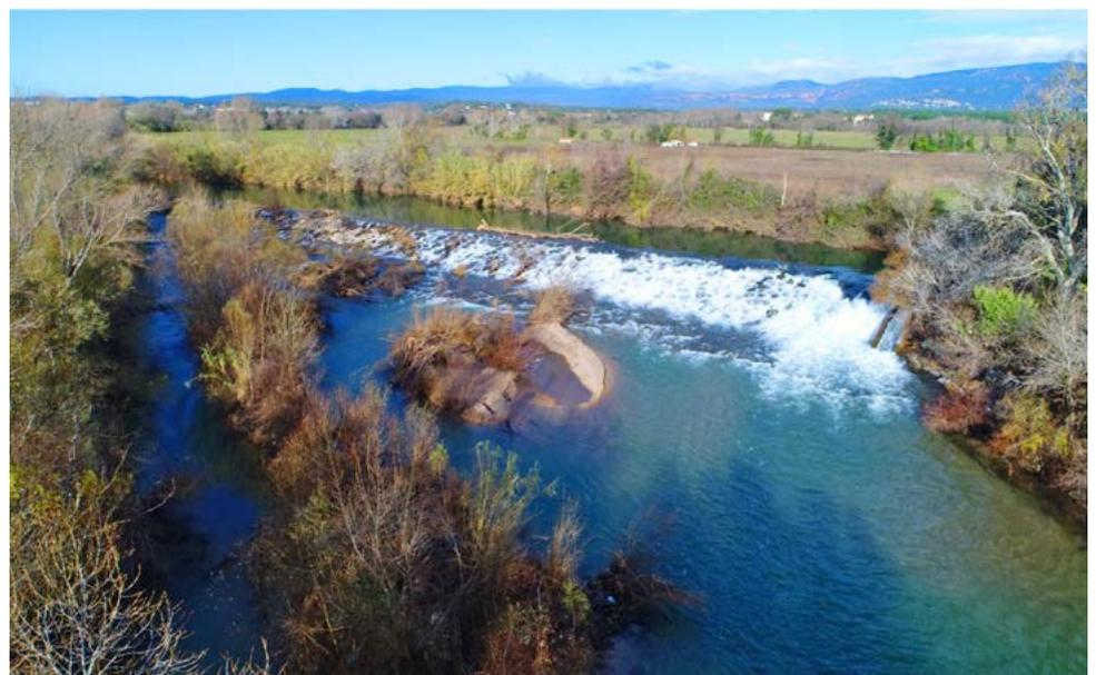
Sur 150 mètres de large et 5 mètres de haut, le seuil du Béal perturbe l'écoulement naturel de l'Argens.
