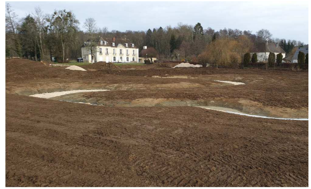
Tracé et recharge du nouveau lit sinueux de la Linotte en fond de vallée © SVO
