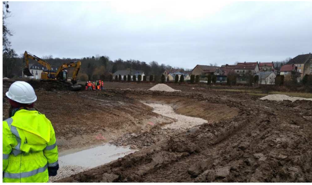
Tracé et recharge du nouveau lit sinueux de la Linotte en fond de vallée © SVO
