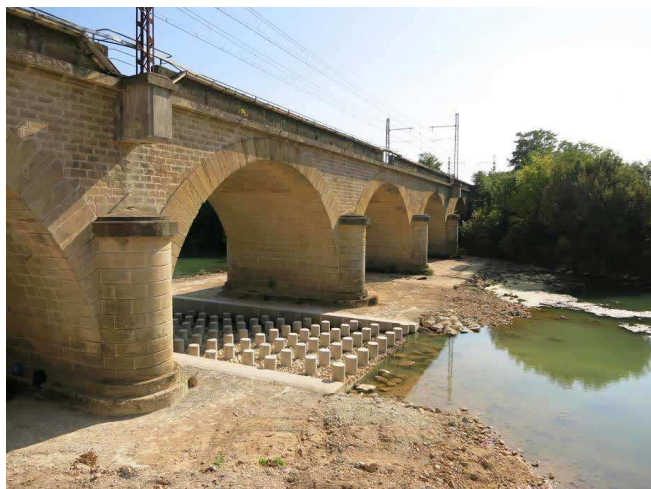
Aménagement d'une passe multi-espèce sous le viaduc ferroviaire © EPTB Vidourle
