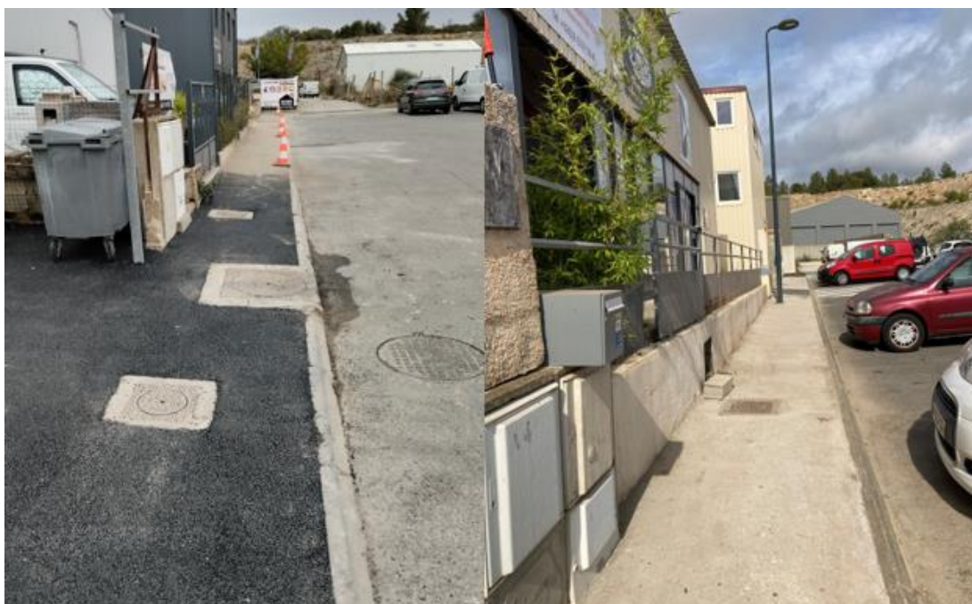
Photographies de trottoirs en coquilles d'huîtres à Leucate avant et après les travaux de désimperméabilisation (source : Samuel Marcinkowski, Grand Narbonne Communauté d'Agglomération)
