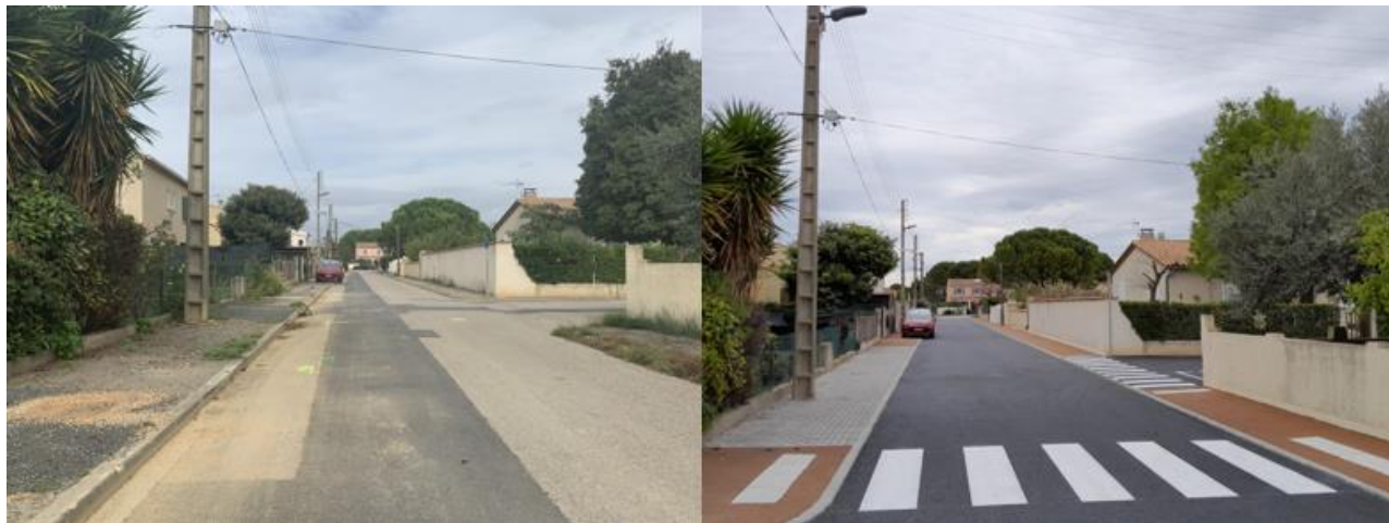
Photographie du quartier Escalaïs à Cuxac d'Aude avant et après les travaux de désimperméabilisation des sols (source : Municipalité de Cuxac d'Aude)
