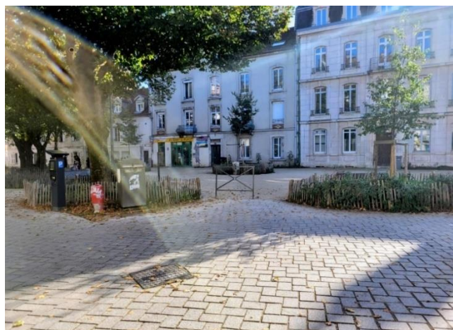
Photographie de la place Maréchal de Lattre de Tassigny à Besançon après les travaux (source : Chloé Vidal)
