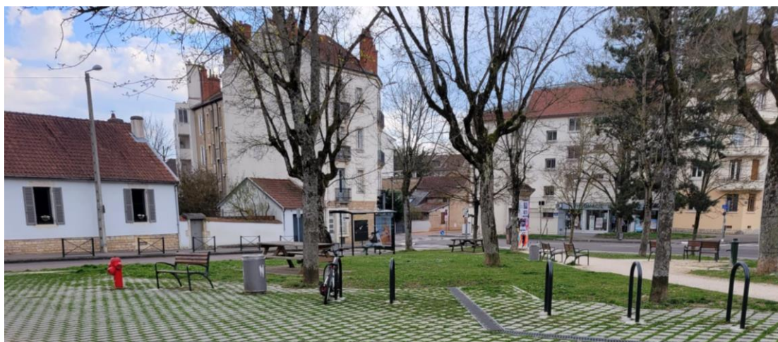
Photographie de la rue de Rouen à Dijon après les travaux (source : Chloé Vidal)
