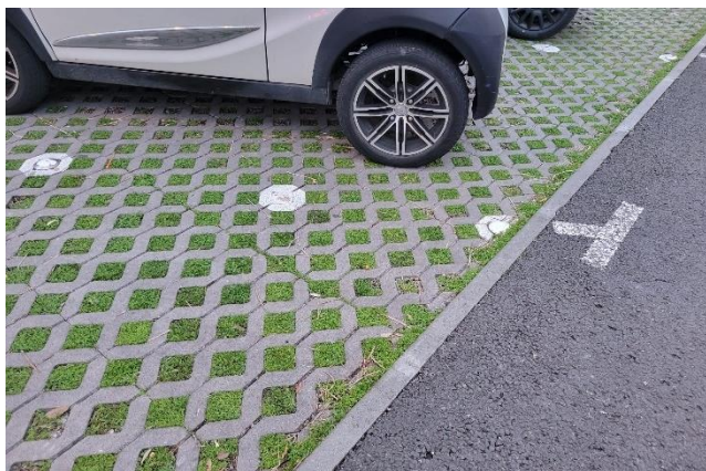
Photographie d'un parking désimperméabilisé à Narbonne (source : Chloé Vidal)
