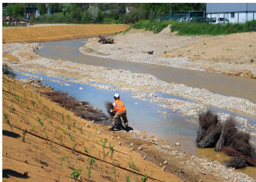
Installation de branches à rejets sur une partie du linéaire de la Nartuby.
