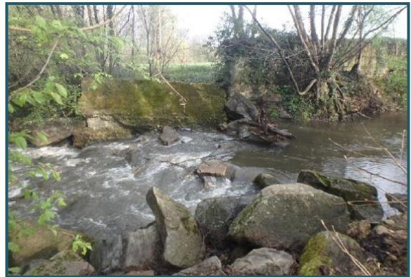
Seuil de fond, enrochement et mur en mauvais état
