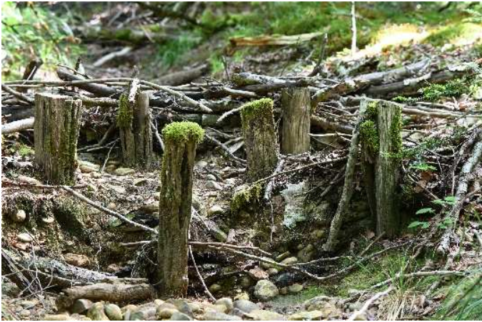
Embâcle de 10 ans. A noter l'embâcle naturel qui s'est formé à l'amont et le dépôt de gravier issu de l'érosion de l'embâcle artificiel à l'aval. © ONF
