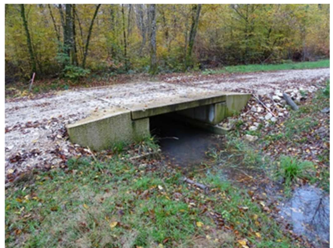
Ouvrage de franchissement refait afin de permettre la continuité écologique © ONF
