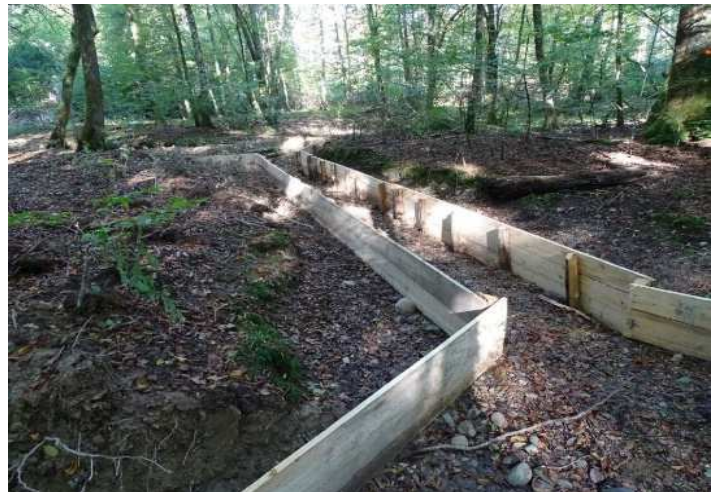
Banquette double avant comblement des rives simple © ONF
