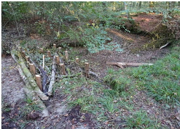
Mise en place de « l'ossature bois » de l'embâcle. © ONF
