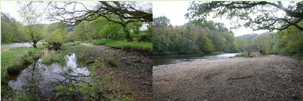
Figure 71 : Illustration des travaux conduits sur la Dordogne visant à aménager la topographie des bancs sur le site du Chambon (©ECOGEA)
