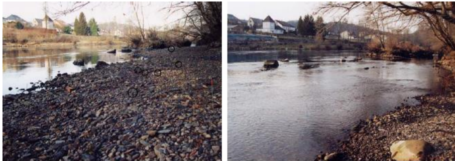
Figure 78 : Vues de la frayère du Lycée d'Argentat au débit de base de 30 \text{ m}^3/\text{s} sur la Dordogne avant et après les travaux (©ECOGEA Cazeneuve et al., 2009).
