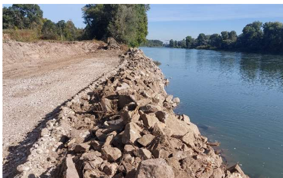
Figure 4 : Phase de démantèlement des ouvrages Girardon (voir définition en paragraphe 4.2) sur casiers de Ciselande, février 2025
