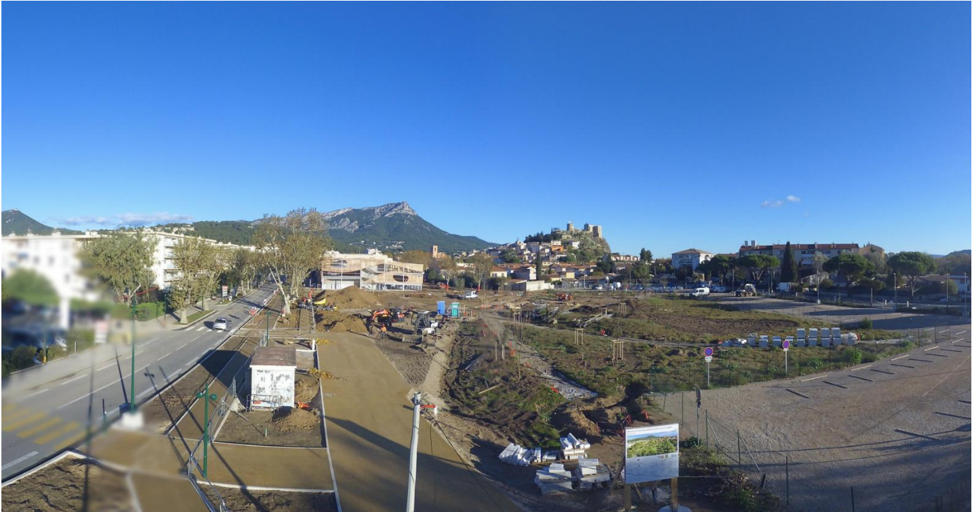
Chantier en cours. Mardi 25 novembre 2025
