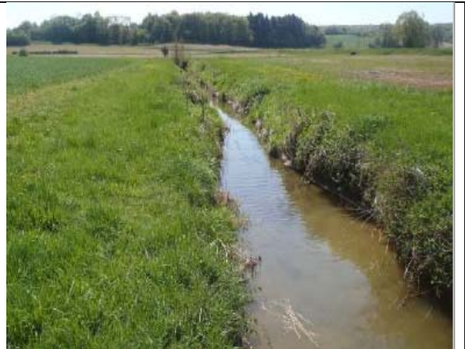
Figure 7b : pour mémoire lit avant travaux
