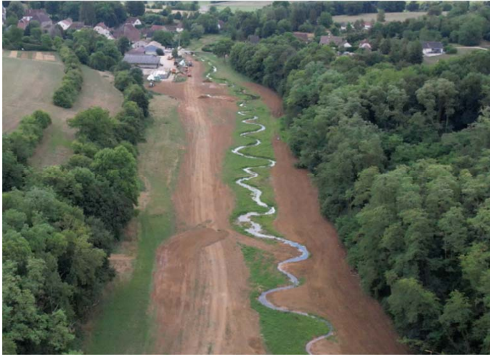
Figure 3 : La Vèze vue de drone après travaux (vue depuis aval, 2025)
