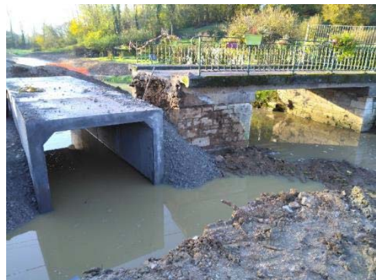
Figure 9 : Dalot disposé en rive droite
