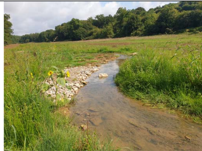
Figure 6 : lit reméandré avec recharge granulométrique en aval du pont dans le secteur où le débordement est facilité
