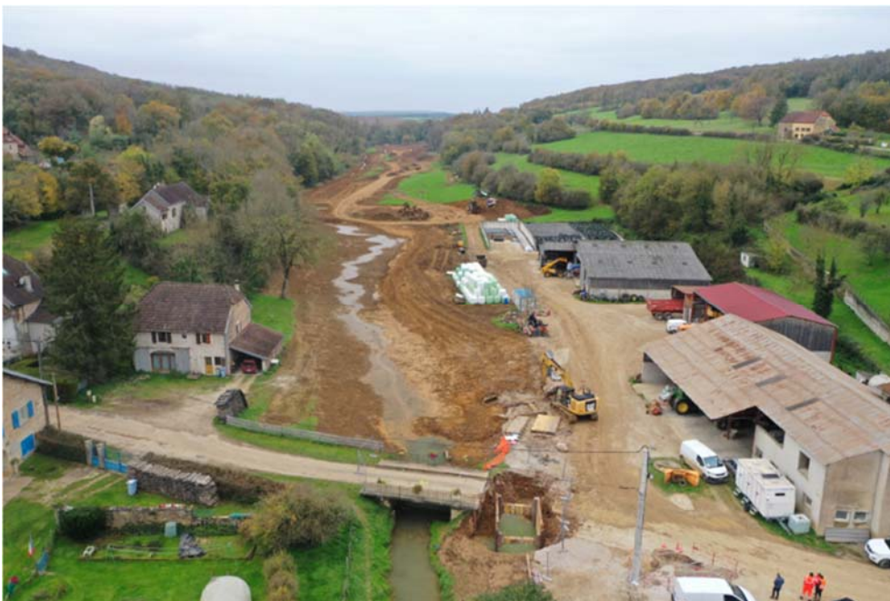
Figure 2 : La Vèze à Taxenne vue de drone pendant les travaux (2025)
