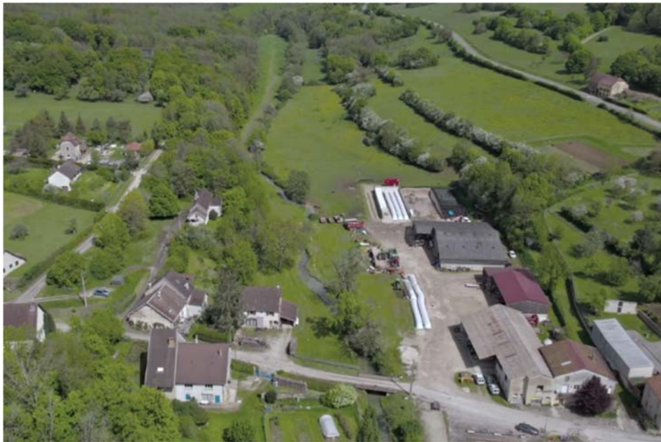
Figure 1 : La Vèze à Taxenne vue de drone avant travaux (2024)
